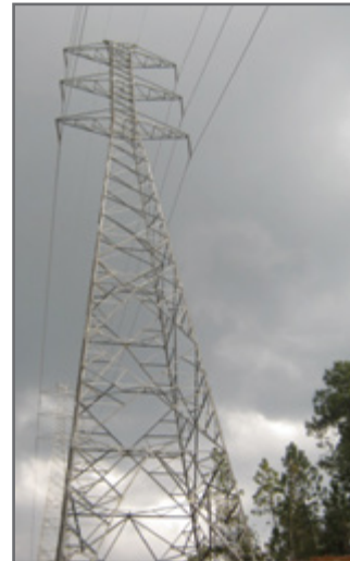
Alimentador SE Huehuetenango 230kV.
