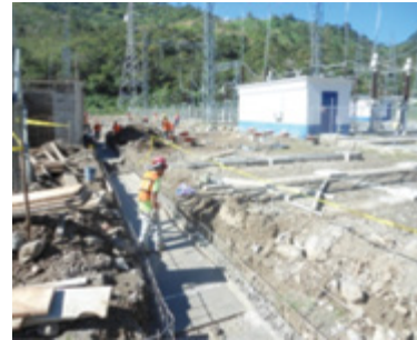
Subestación Covadonga 230 kV
