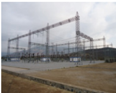
Subestación San Agustín 230/69 kV
