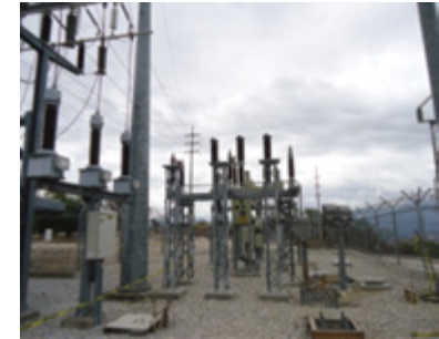
Subestación El Rancho 69 kV
