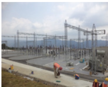
Subestación Palestina 230 kV
