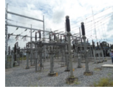
La Ruidosa 69 kV
