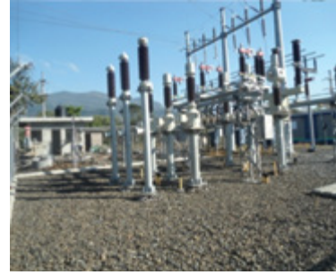
El Estor 69 kV
