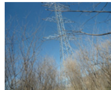
Morales - Panaluya 230 kV
