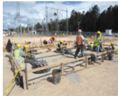
Huehuetenango II 230/138 kV
