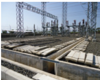
Subestación Izabal 230/69 kV
