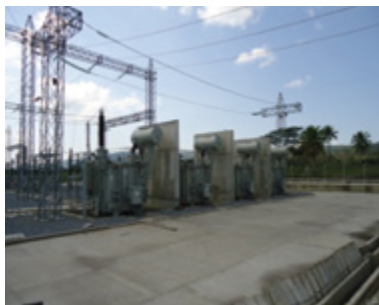
Subestación Morales 230/69 kV
