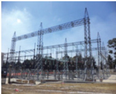
Guate Sur 230 kV
