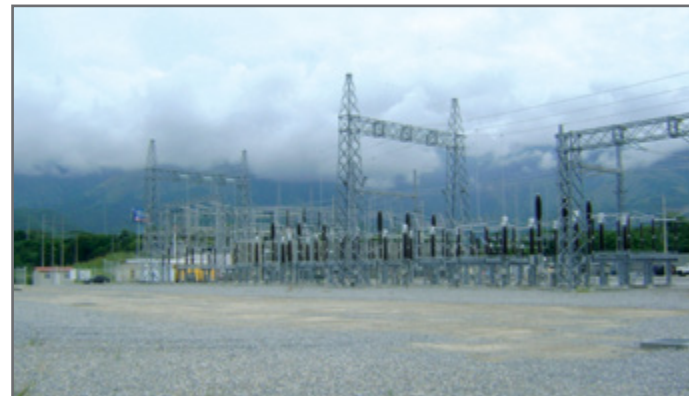
Ampliación SE Panaluya 230kV
